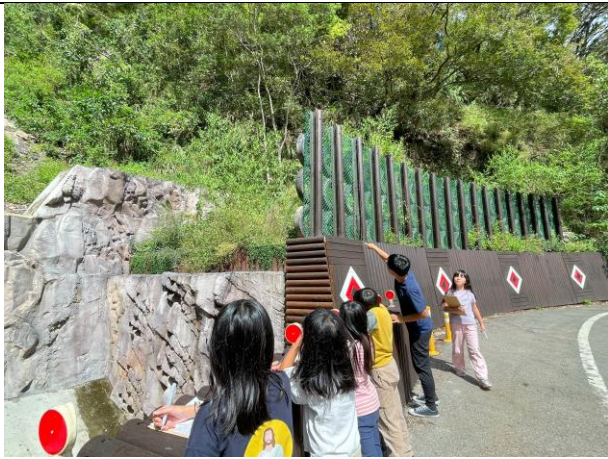
說明：觀察三光國小正門道路上的梳子壩落石防治設施。
